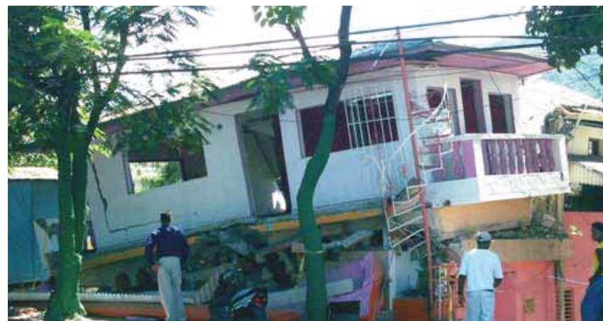
Vivienda colapsada en Puerto Plata, sismo 2003. Foto: Osiris de León.
