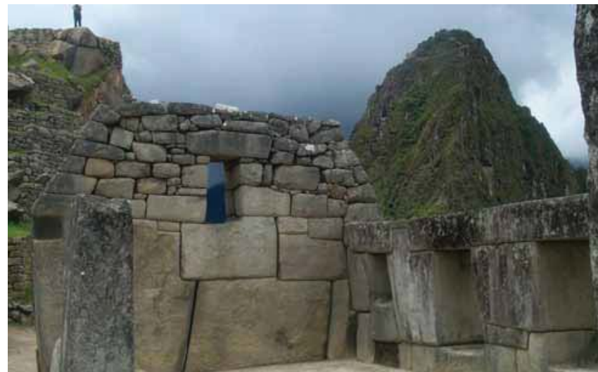
Muros construidos por los Incas para resistir grandes sismos en la zona sísmica de Macchu Pichu, Cuzco, Perú. Fotos: Osiris de León
