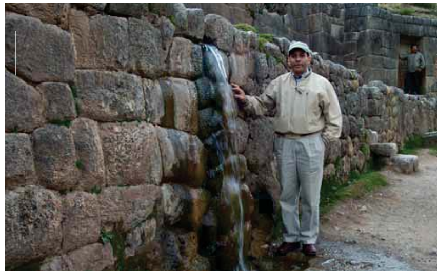
Muro de mampostería inca construido a prueba de sismos en Macchu Pichu. Foto: Osiris de León.
