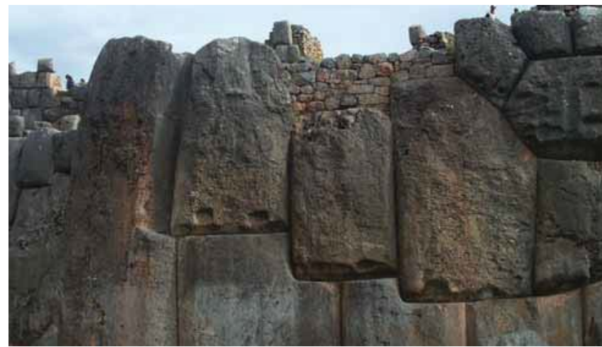
Muros construidos por los Incas para resistir grandes sismos en la zona sísmica de Macchu Pichu, Cuzco, Perú. Fotos: Osiris de León
