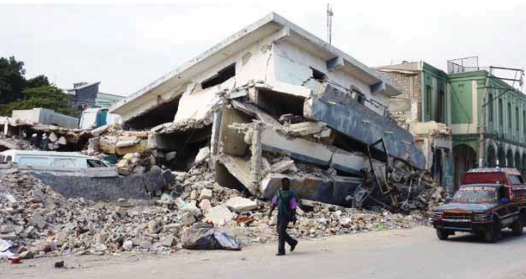
Edificio aplastado en el Centro de Puerto Príncipe. Foto: Osiris de León.
