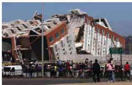
Edificio y viaducto aplastado por el sismo de Chile. 27 febrero 2010. Fotos: Fuente externa
