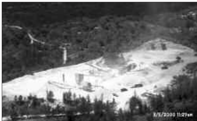
Fig. 10. Cantera de piedra caliza para producción de agregados en El Pomier de San Cristóbal
